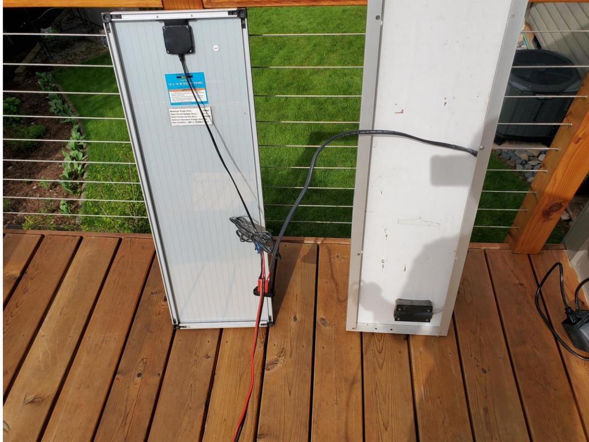
NEXT CONNECT THE SOLAR POWER CABLE TO THE CHARGE CONTROLLER AND ADD YOUR RADIO
